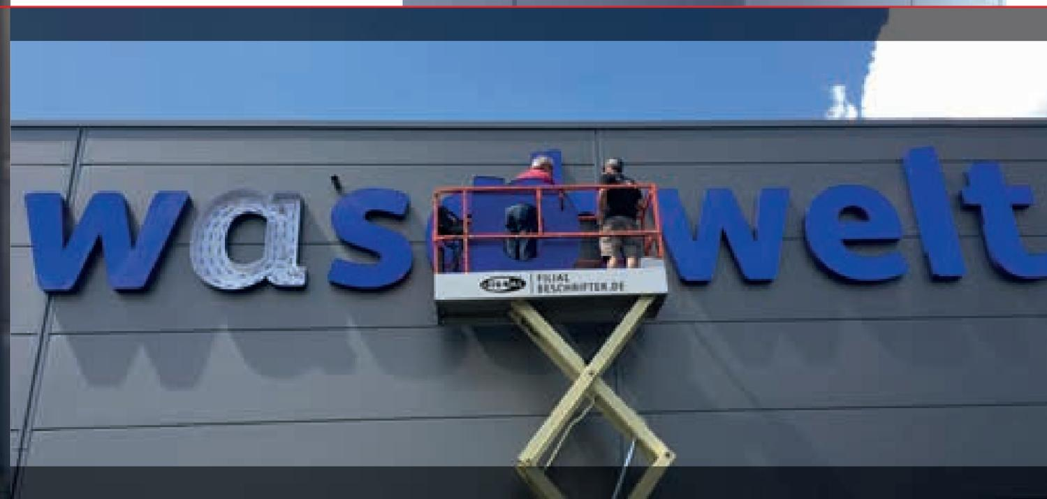
Das Profil 5S besteht aus einem Metallkörper in Ihrer Wunschfarbe nach RAL lackiert und einer folierten Acrylfront. Ideal für große Schriften mit guter Fernwirkung. An der Kante des Acryls bleibt ein kleine weißer Rand stehen. Lack- und Folienfarbe differieren, ebenso die Tag- und Nachtwirkung.
